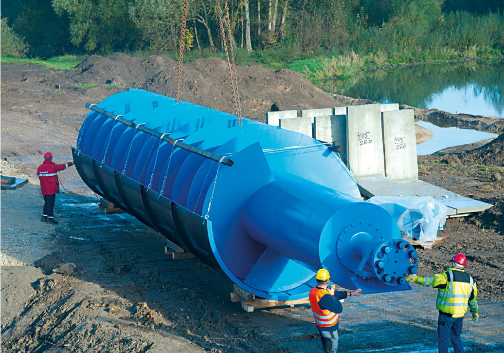
Modernste Wasserkrafttechnik, eine 20 Tonnen schwere "Wasserkraftschnecke", wurde in Neuses an der Regnitz verbaut.
