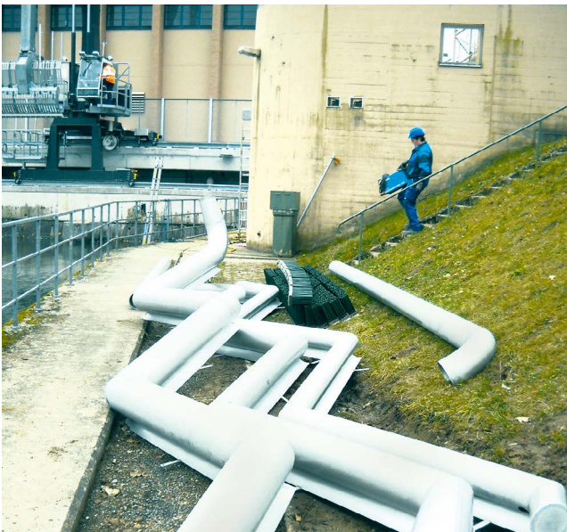
Zickzackrohr als Fischabstiegseinrichtung
