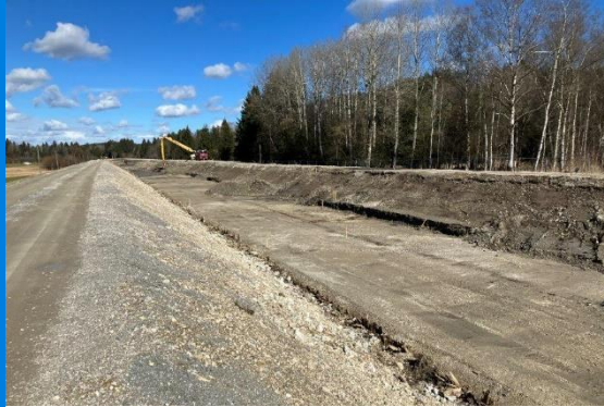
Kanalquerschnitt und Sohle herstellen.
