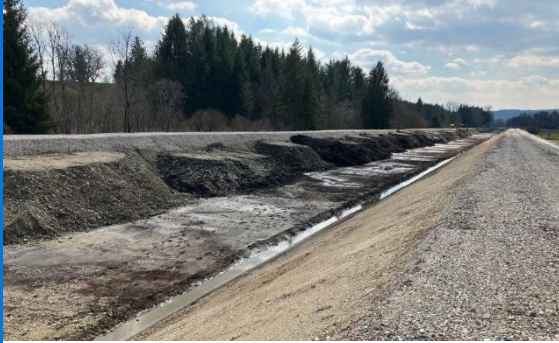
Kanalquerschnitt herstellen, Haufwerke für Abtransport und Entsorgung vorbereitet.
