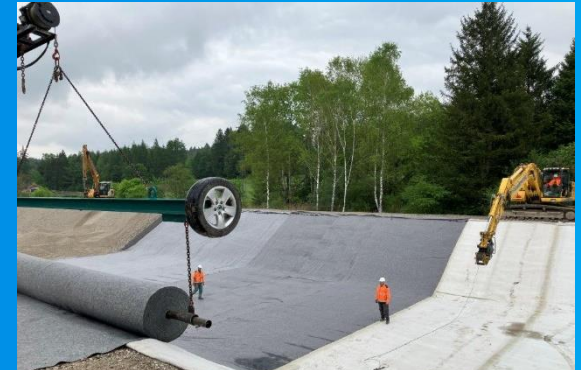
Einbau von GTD, Vlies und Geogitter.
