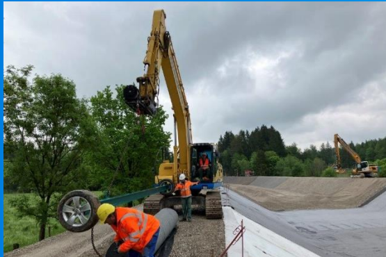
Einbau von GTD, Vlies und Geogitter.
