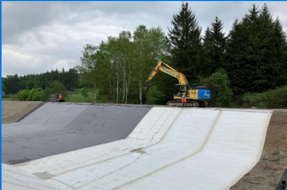
Einbau von GTD, Vlies und Geogitter.
