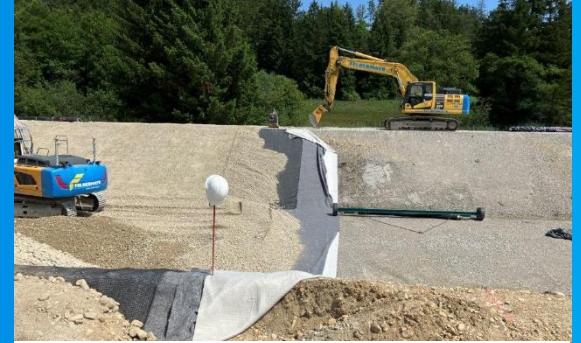
Einbau von GTD, Vlies und Geogitter inkl. Einbindegrabe.
