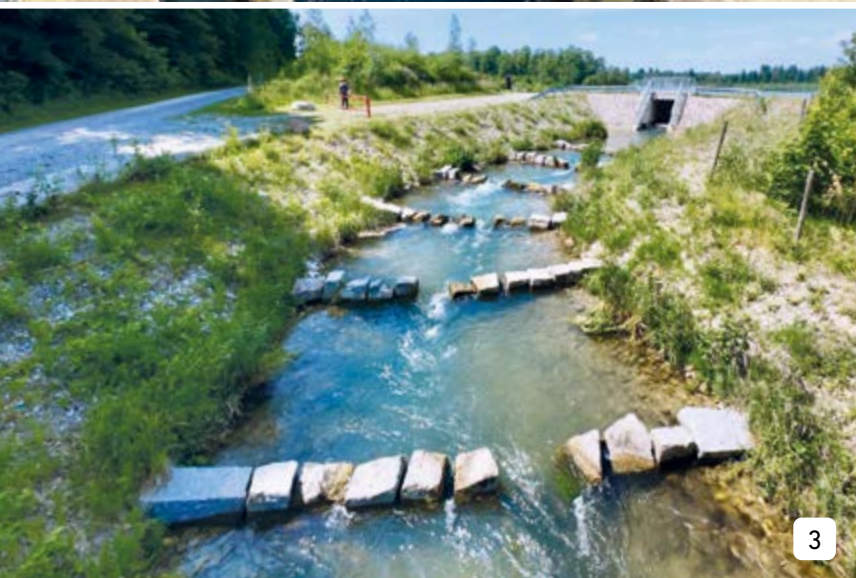
(1) Einstiegsbauwerk der Fischwanderhilfe am Kraftwerk Kaufering
