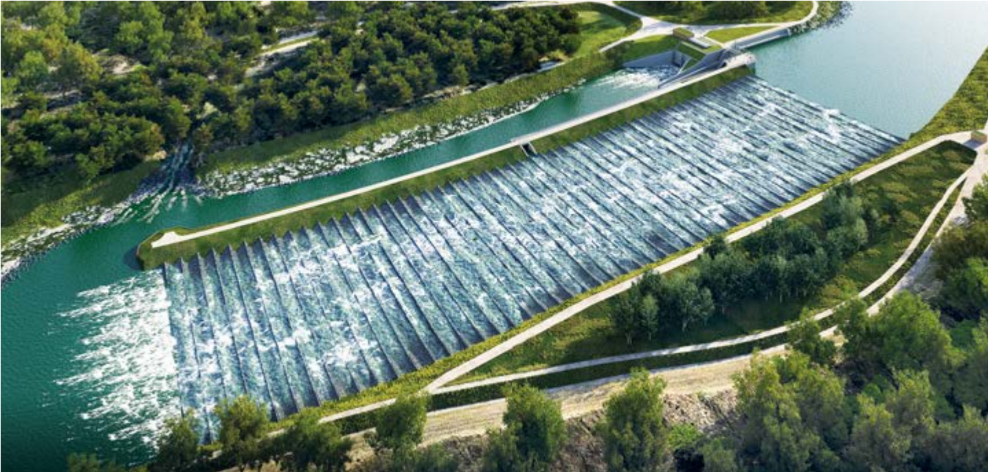
Visualisierung der Planung für die „Rauhe Rampe“ – ergänzt um ein modernes Wasserkraftwerk. (Illustration von Uniper in Orientierung am Stand der Planfeststellungsunterlagen von 11/2025)
