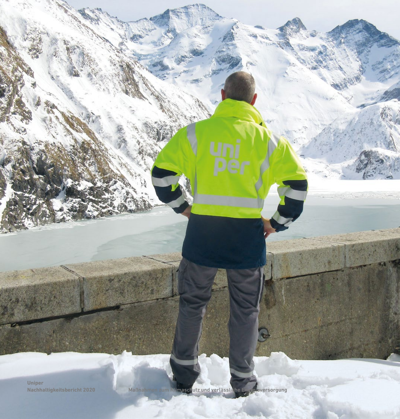
Ein Uniper Mitarbeiter am Pumpspeicherkraftwerk in Kaprun, Österreich
