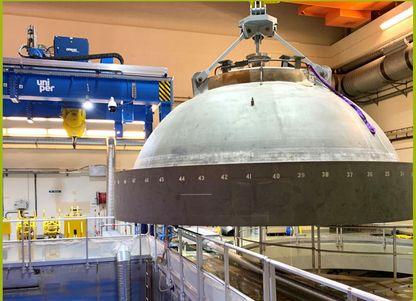
Anheben des Reaktordruckbehälter-Deckels (RDB)
