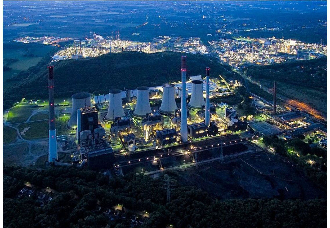
Kraftwerk Scholven in Deutschland
