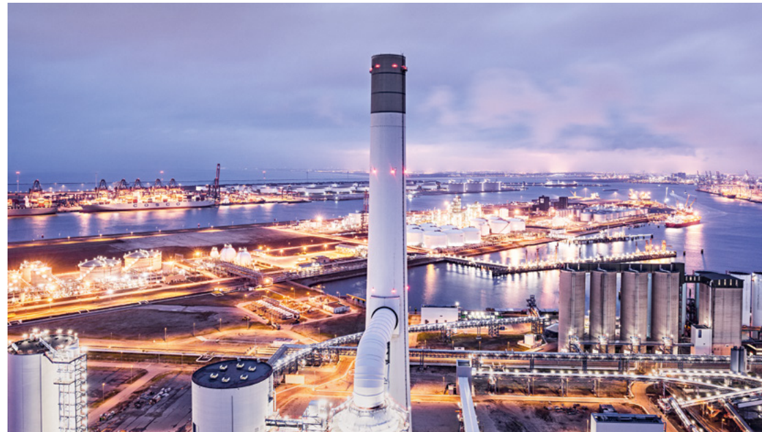
Kohlekraftwerk Maasvlakte in den Niederlanden
