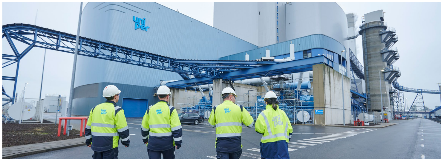
Uniper Steinkohlekraftwerk Maasvlakte in den Niederlanden
