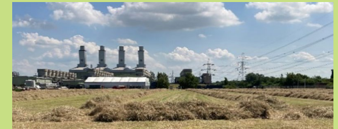
Kraftwerk Connahs Quay in Großbritannien
