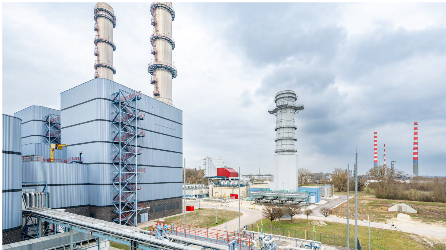
Uniper-Kraftwerk Irsching in Deutschland
