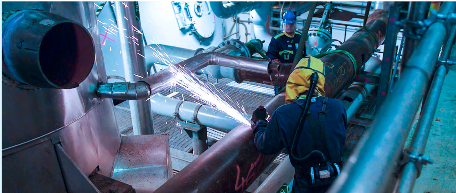
Rückbau des Kernkraftwerks Barsebäck
