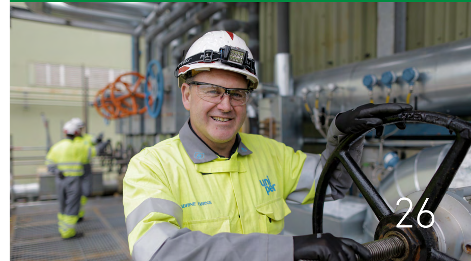
Kraftwerk Connah's Quay in Großbritannien
