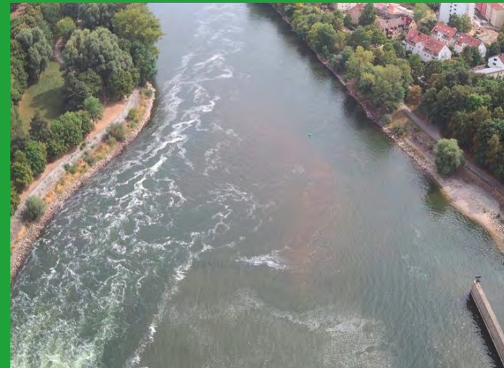
Sauerstoffmessung im Regensburger Wasserkraftwerk
