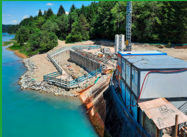
Bau von Wanderhilfen für Fische am Lech
